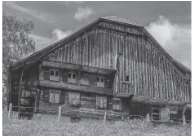
Falkenbach in Flühli, 1957 gekauft und ausgebaut
